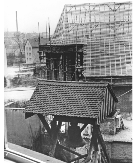
1955 erhält der Chorraum seinen neuen Dachstuhl. Im Vordergrund der Glockenträger
