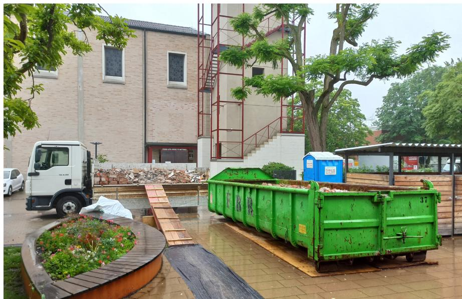
Zum Zeitpunkt des Redaktionsschlusses wurde ein Gerüst rund um das Gemeindehaus aufgebaut und die Fassade gereinigt. Hier müssen Frost- und Witterungsschäden ausgebessert werden. Eine Hydrophobierung soll die Fassade vor Witterungseinflüssen in Zukunft besser schützen.
